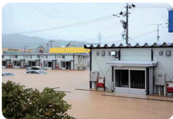
浸水した仮設住宅 ※朝日新聞社提供
